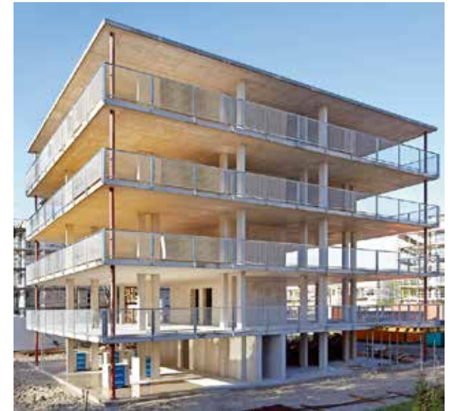
Figura 1.24: Foto da estrutura concluída do projeto do escritório BeL Architects.
